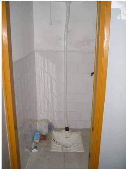
Eine der beiden Toiletten, kurz vor der Fertigstellung
